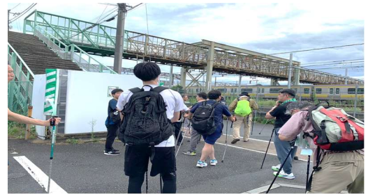
三鷹・跨線橋
